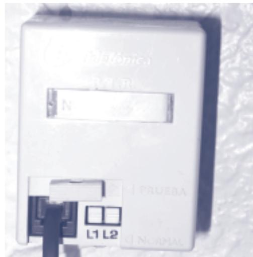
Fig. 1.3. Punto terminal de red RTC.
